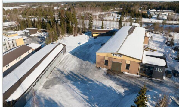
ATI-Teräksen nykyaikaiset toimitilat sijaitsevat Jokioisissa aivan valtatie 10:n varrella. Tontin koko mahdollistaa myös tilojen kasvattamisen toiminnan kasvun niin vaatiessa.
